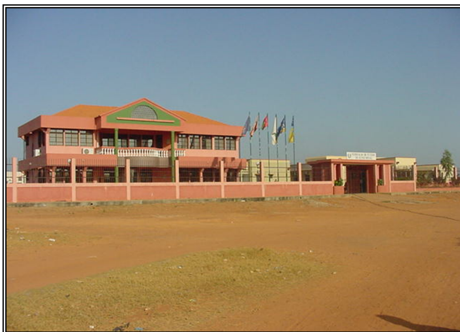
Fig. 16 – Prédio da federação
